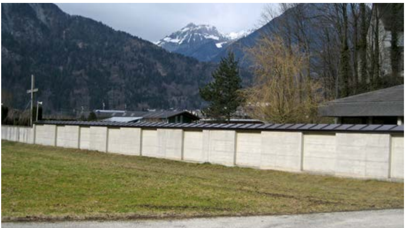
Erneuerung der Abdeckung bei der Friedhofsmauer
