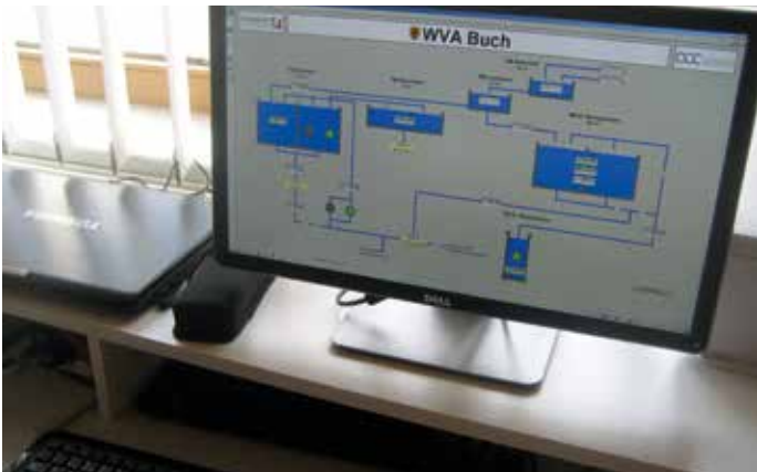
Erneuerung der EDV Anlage für die Wasserversorgung im Bauhof
