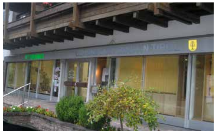
Neugestaltung des Einganges (Gemeindeamt Attika)
