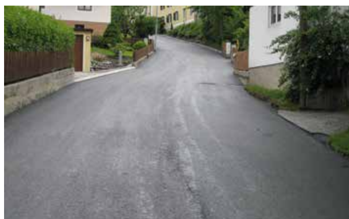
Erneuerung Asphaltierung des gesamten Grausbühel
