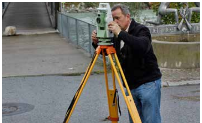
Fortführung der Vermessungsarbeiten Leitungs- Katasterplan im Gemeindegebiet
