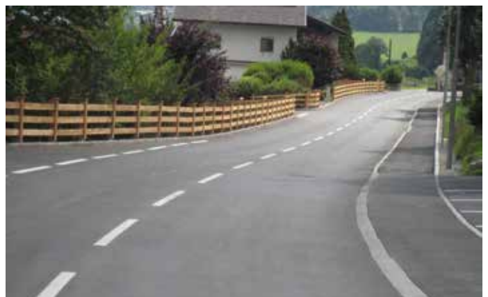
Errichtung eines neuen Gehsteiges entlang der Landesstraße im Ortsteil Buch, sowie Neueinfassung der Oberflächenentwässerung, Hydranten, uvm...
