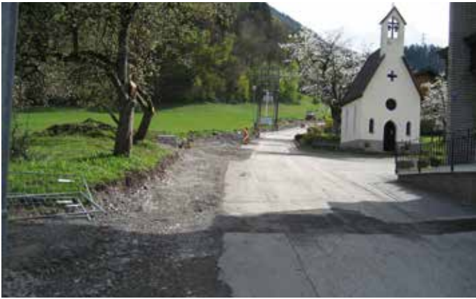
Erneuerung der Wasserleitung Innermaurach sowie Hausanschlüsse und Hydranten
