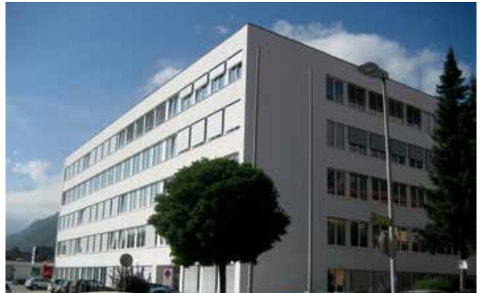
Beteiligung Ausbau und Sanierung bei der neuen Mittelschule Jenbach
