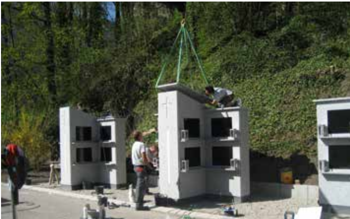
Neuerrichtung und Erweiterung der Urnengräber beim neuen Friedhof in St. Margarethen
