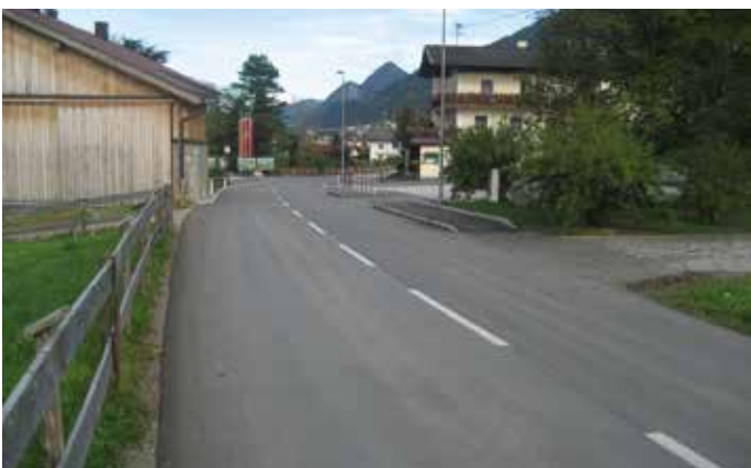
Neuasphaltierung der Landesstraße im gesamten Abschnitt
