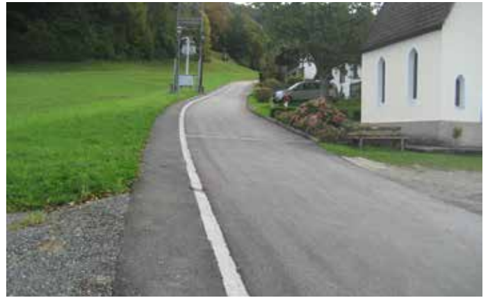
Errichtung eines Gehsteiges in Innermaurach, Neuasphaltierung des gesamten Bauabschnittes Innermaurach
