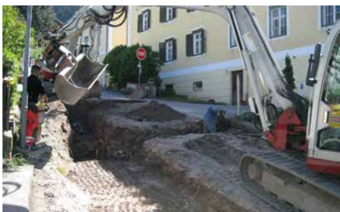
Erneuerung der Wasserleitung, Hausanschlüsse, Hydranten und Absperrer, Grausbühel Rotholz
