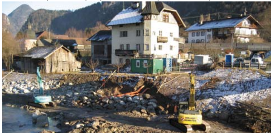
Innuferverbauung beim Notburgasteg Rotholz
