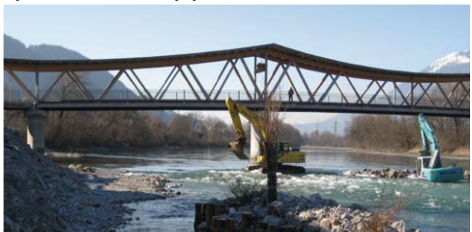
Innuferverbauung beim Notburgasteg Rotholz - Entfernung der alten Widerlager
