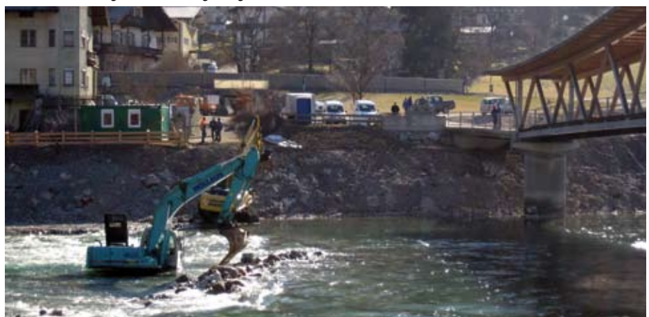
Innuferverbauung beim Notburgasteg Rotholz
